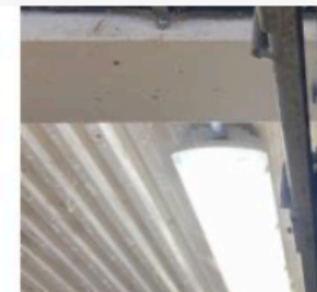
Rail Delaval pour les porteurs de trayeuses, environ 400 pieds
